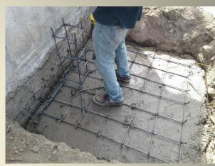
4.- Concreto. Se verterá el concreto f'c= 250 kg/cm2 sobre toda la zapata. Cuidando de que la parte superior quede nivelada.
