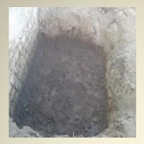
2.- Plantilla de concreto pobre. Se vaciara una plantilla de concreto pobre f'c= 150 kg/cm2, para evitar que se contamine el concreto de la zapata.
