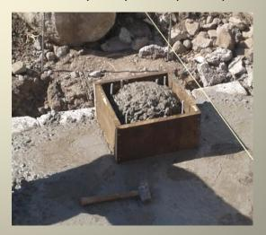
5.- Colocación de grout. Se añadirá una capa de grout para que la placa de acero quede totalmente nivelada.
