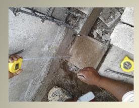
6.- Colocación del aislador. Una vez vertido el grout y checado que todo esta a nivel, se coloca el aislador sísmico, cuidando de que quede perfectamente nivelado.
